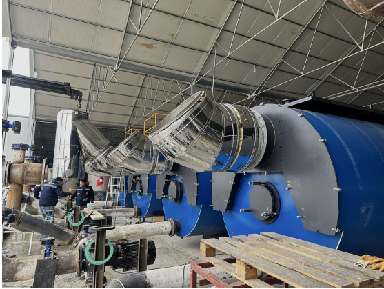
Afyon Alarko · Baca bağlantılarının montajı
