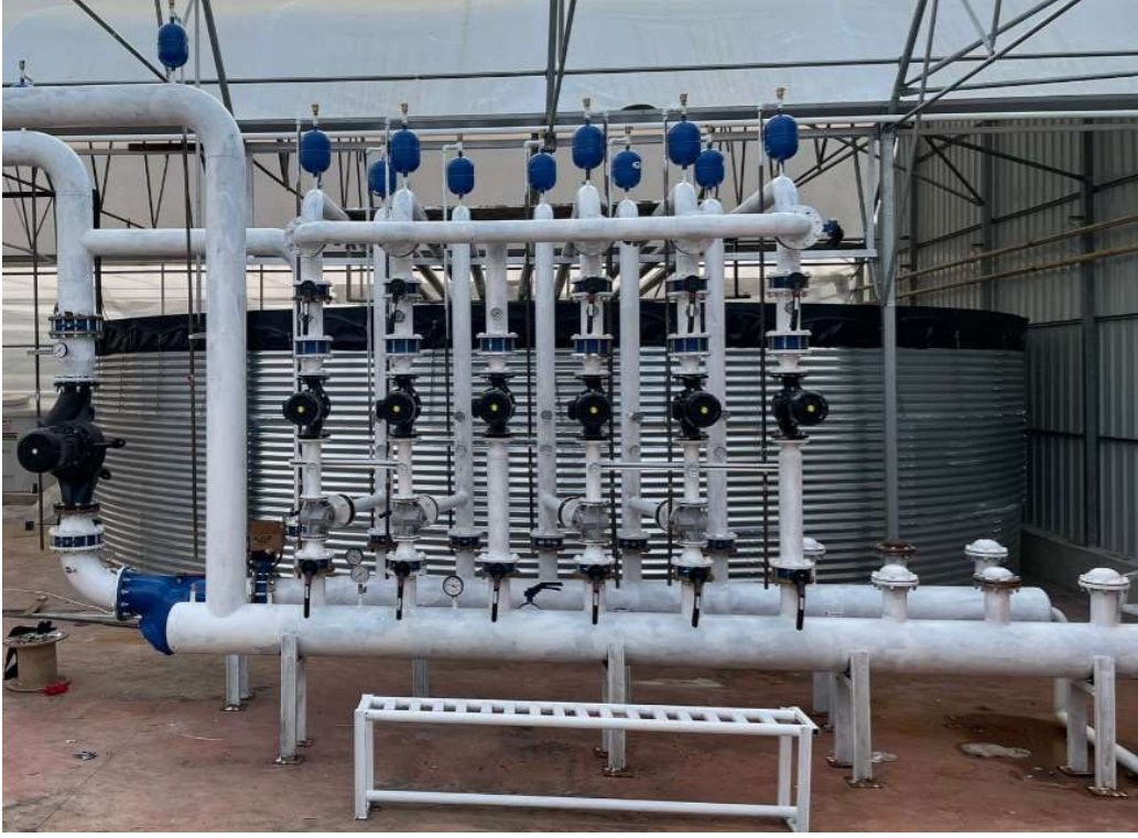
Aynı geçici teslim belgesindeki kollektör grubu · Montaj aşamasının saha fotoğrafı.
